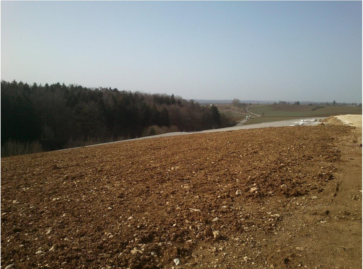
Abb. 3: Deponie Grund, Lonsee-Ettlenschieß (Vordergrund: eingebaute Rekultivierungsschicht, Hintergrund: mineralische Entwässerungsschicht)
