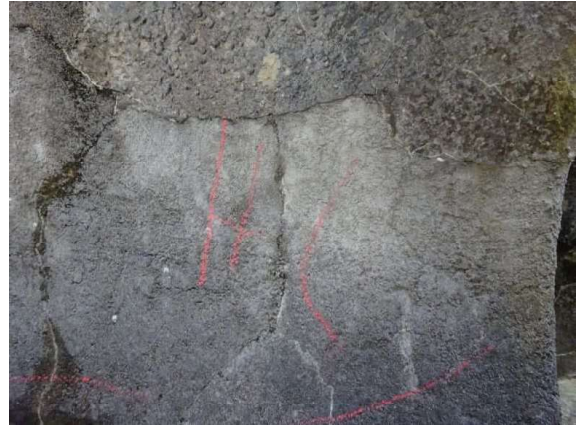
HP2021_HOHLLAGE STÜTZMAUER
