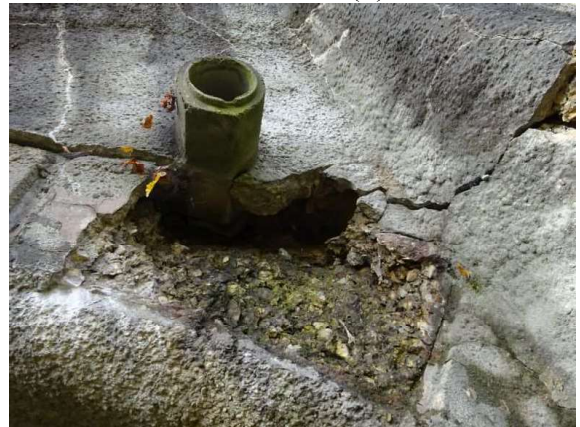
HP2021_ABPLATZUNG VERBLENDUNG
