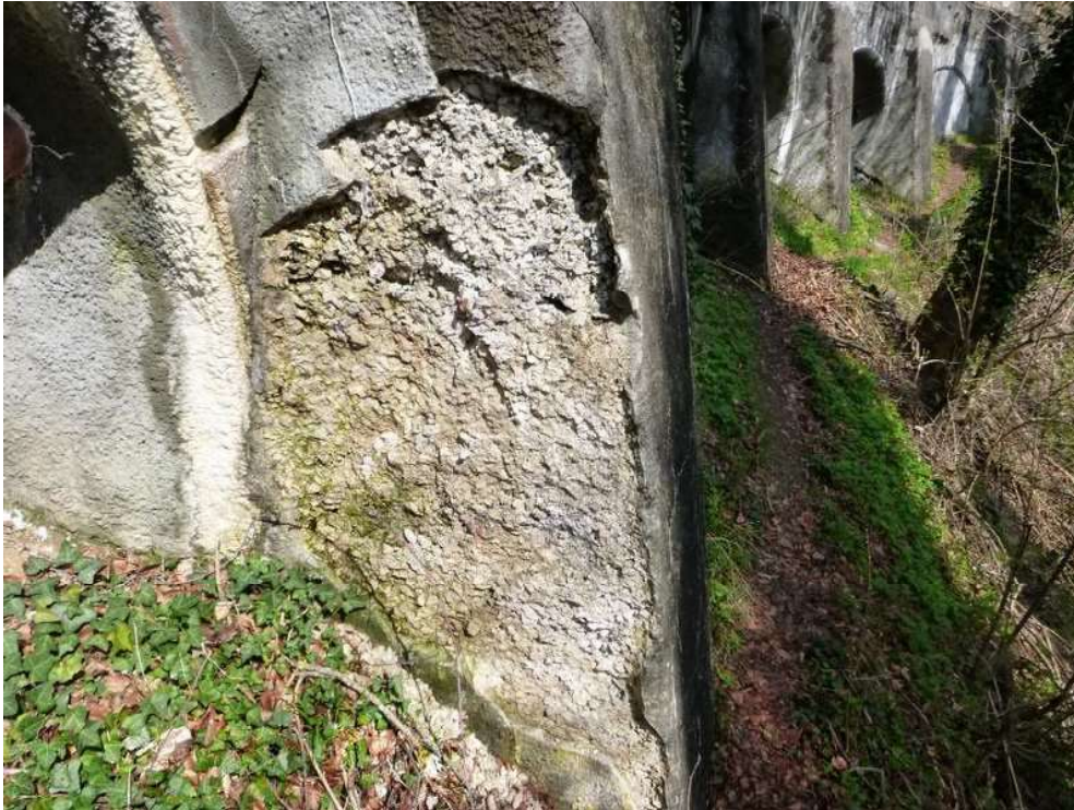
7524526_2016H_13-AUSBRÜCHE PFEILERSGESIMS SEGMENT XXIV
