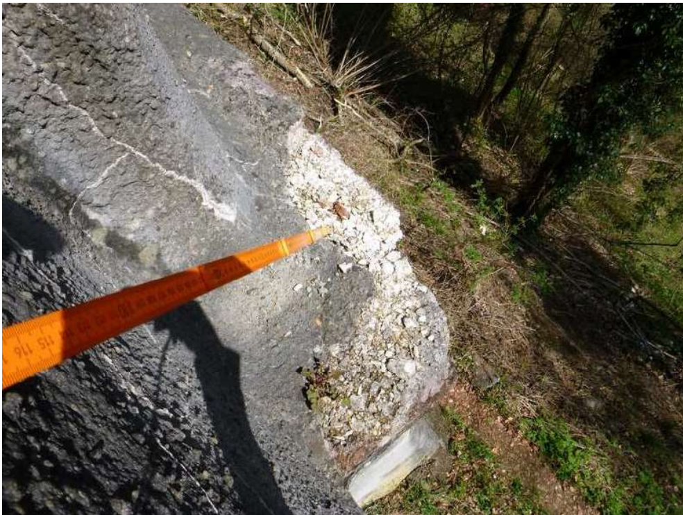
7524526_2016H_13-AUSBRÜCHE PFEILERSGESIMS SEGMENT XXIV
