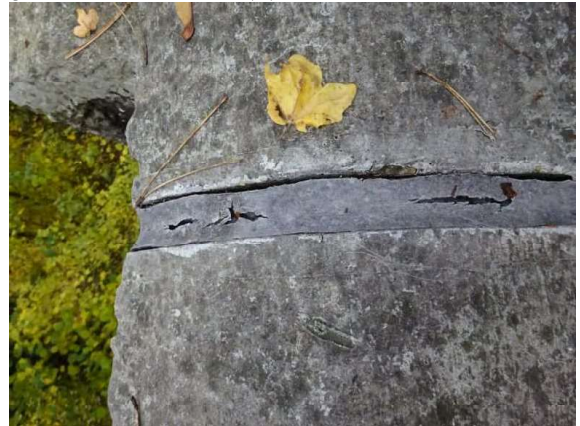
HP2021_FUGENFÜLLUNG SCHADHAFT
