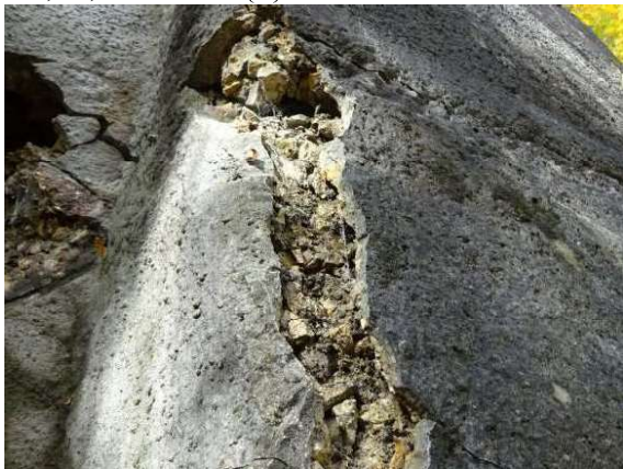
HP2021_FROSTSCHADEN PFEILER
