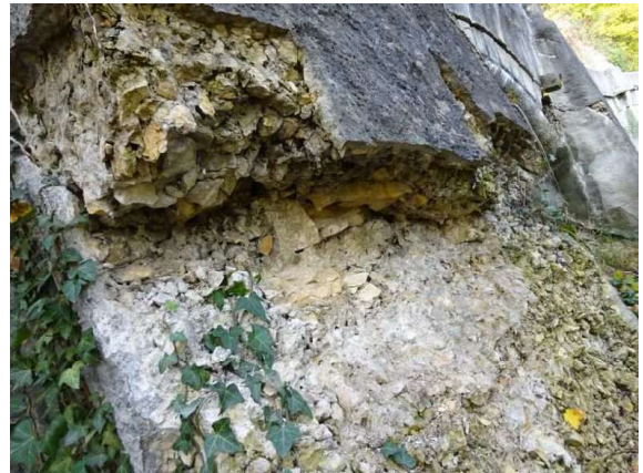
HP2021_MASSIVER FROSTSCHADEN
