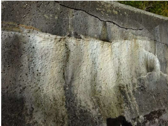
HP2021_AUSSINTERUNG BRÜSTUNG
