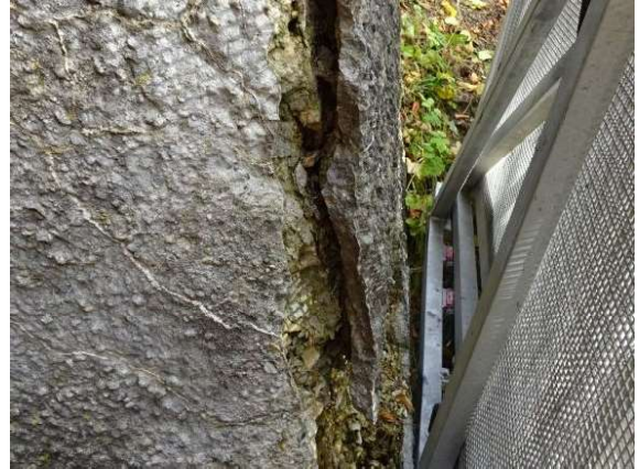
HP2021_HOHLLAGE STÜTZE
